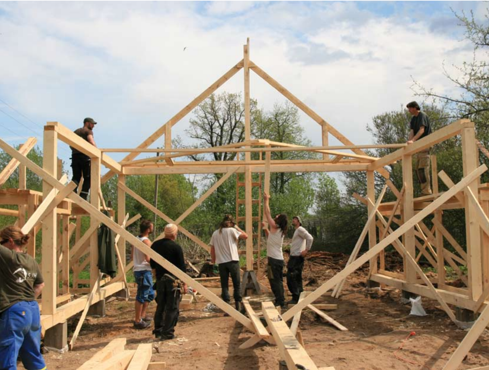
Takstolane settes på plass.
