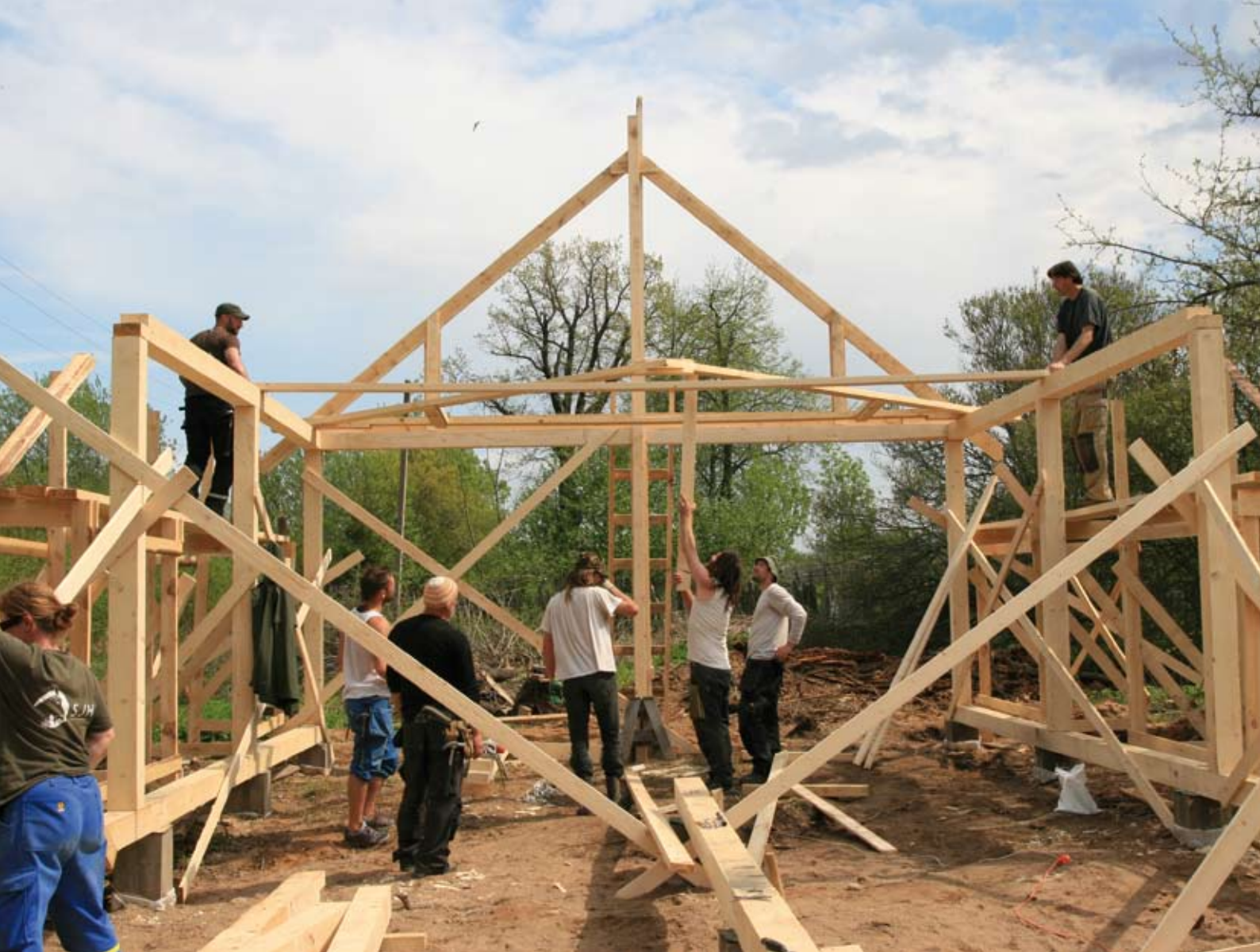
Takstolane settes på plass.
