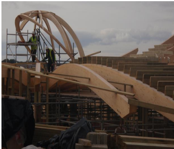
Figur 3, "Å byggja ut frå staden" The Fieldsenter tek form, Foto: Jorun Barane
